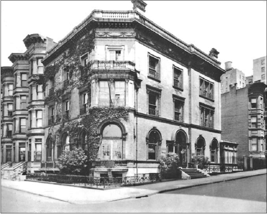
Старое здание Музея Рериха. 310 Riverside Drive. МНР
